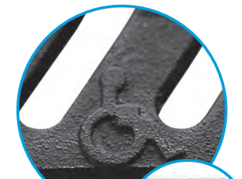
Fiets en rolstoel vriendelijk: De sleuven van de roosters zijn nooit groter dan 20 mm.
